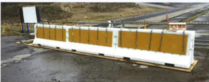
コンパネと鉄筋による はらみ防止 支保工
