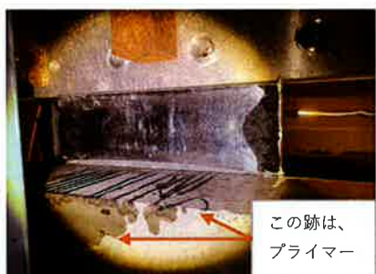
簡易水張り 漏水なし この跡は、プライマー
