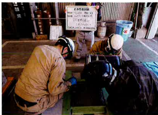
PA溶剤流込（第2レイヤー） 1
