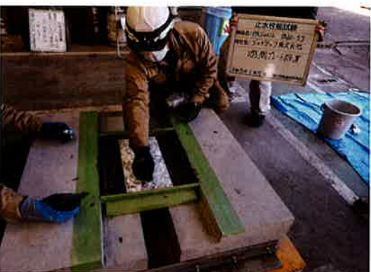
遊間プレート設置 1
