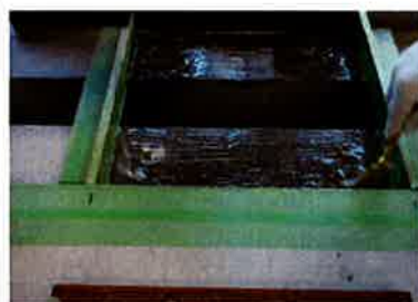
プライマー塗布
