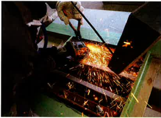
アンカー切断
