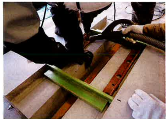
アンカー孔削孔（特殊目地材貼り付け） 2
