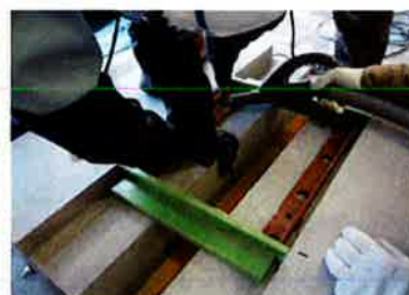
アンカー孔削孔 (特殊目地材貼り付け)
