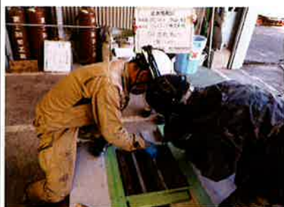
PA溶剤流込 (第1レイヤー)
