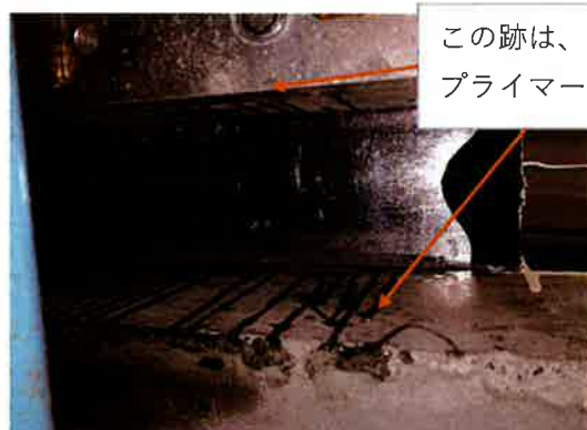
終了時簡易水張り 下面 漏水なし
