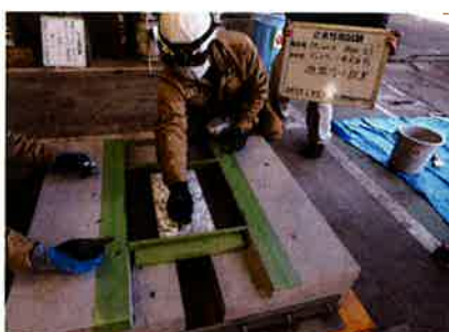
遊間プレート設置
