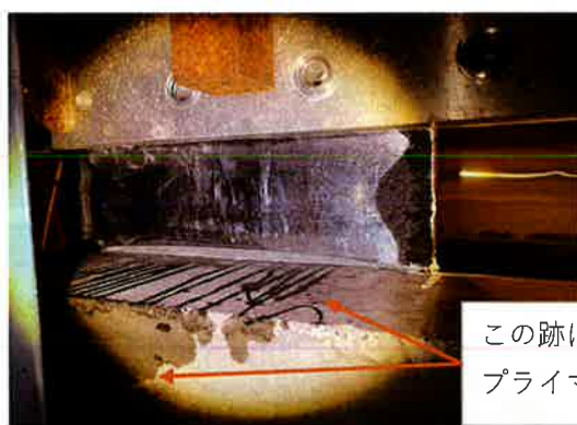
中間時簡易水張り 下面 漏水なし
