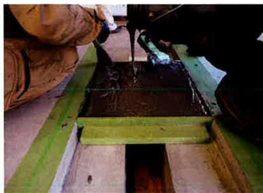
PA溶剤流込（第2レイヤー） 2
