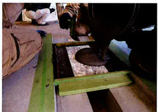
遊間プレート設置 2
