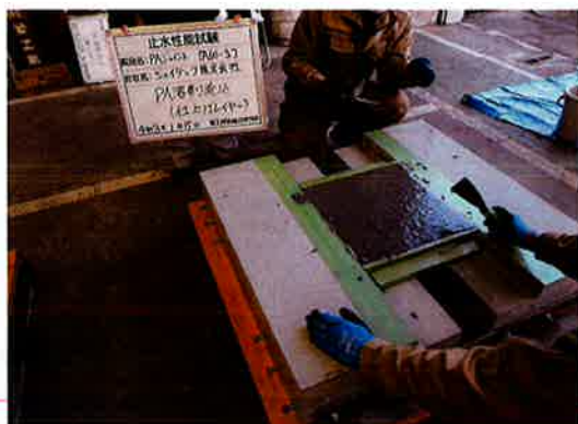
PA溶剤流込（仕上げレイヤー）
