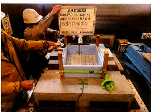
水張り試験開始 (正面)
