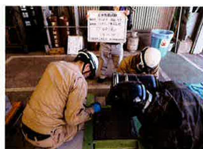
PA溶剤流込 (第2レイヤー)
