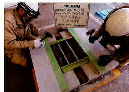
コンクリート等貼付 アンクル設置 2
