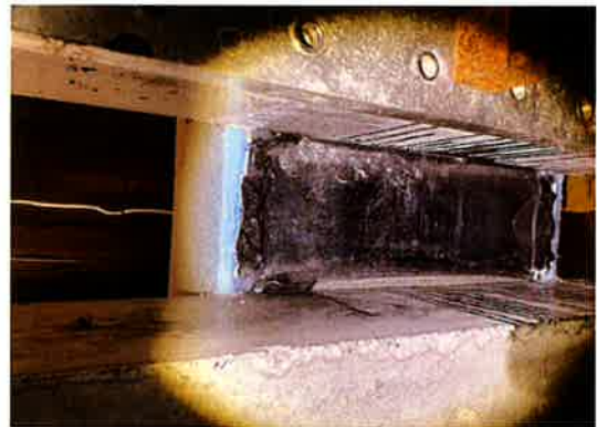
水張り試験終了 下面 漏水なし
