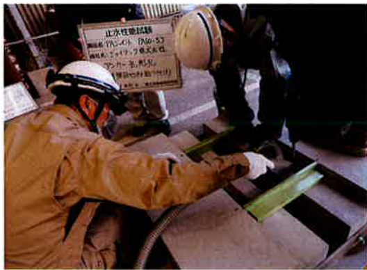
アンカー孔削孔（特殊目地材貼り付け） 1
